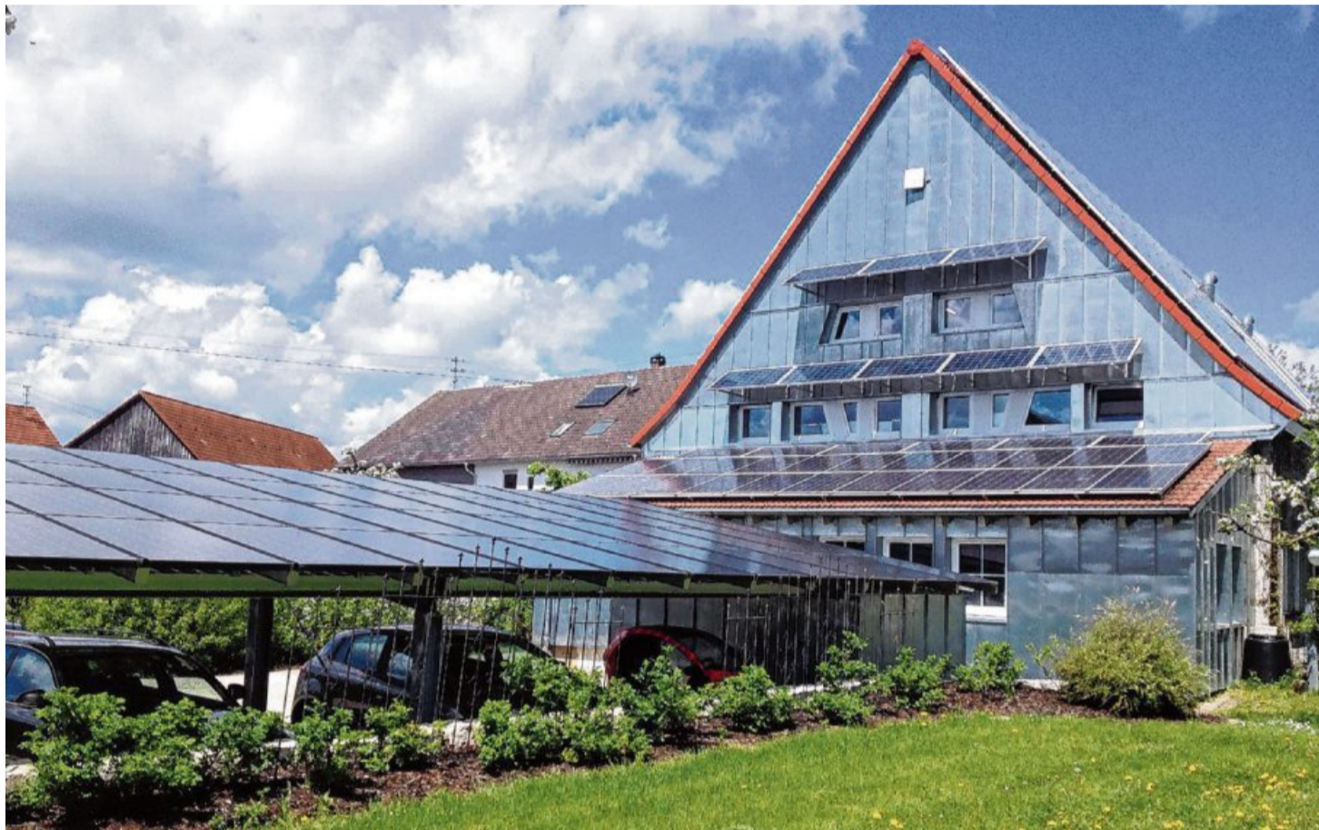
Eine Energie-Fassade bietet auch gestalterisch viele Möglichkeiten, wie hier am Firmensitz von Walter Konzept, der zudem mit einem Solar-Carport ausgestattet ist. Foto: Walter Konzept
