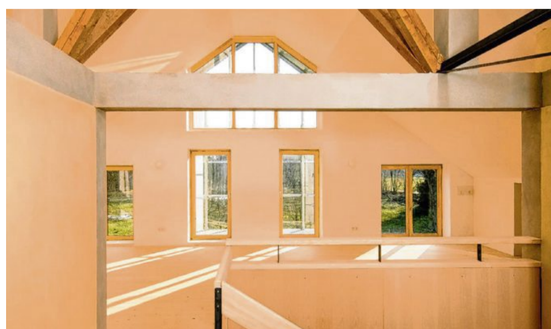
Für ein gesundes Wohnklima: Hier haben die Stuckateurprofis von Beck einen Kalkschutz im Dachgeschoss aufgetragen. Foto: Beck
