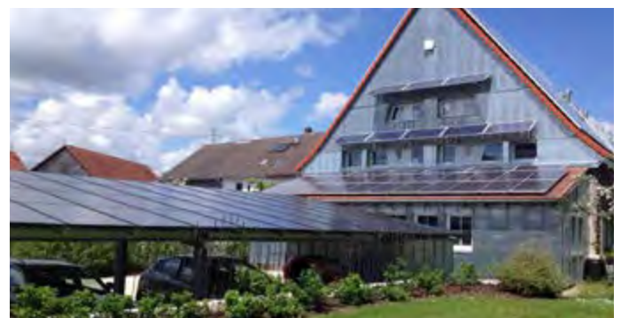
Bürogebäude von WALTER konzept in Ellwangen.
