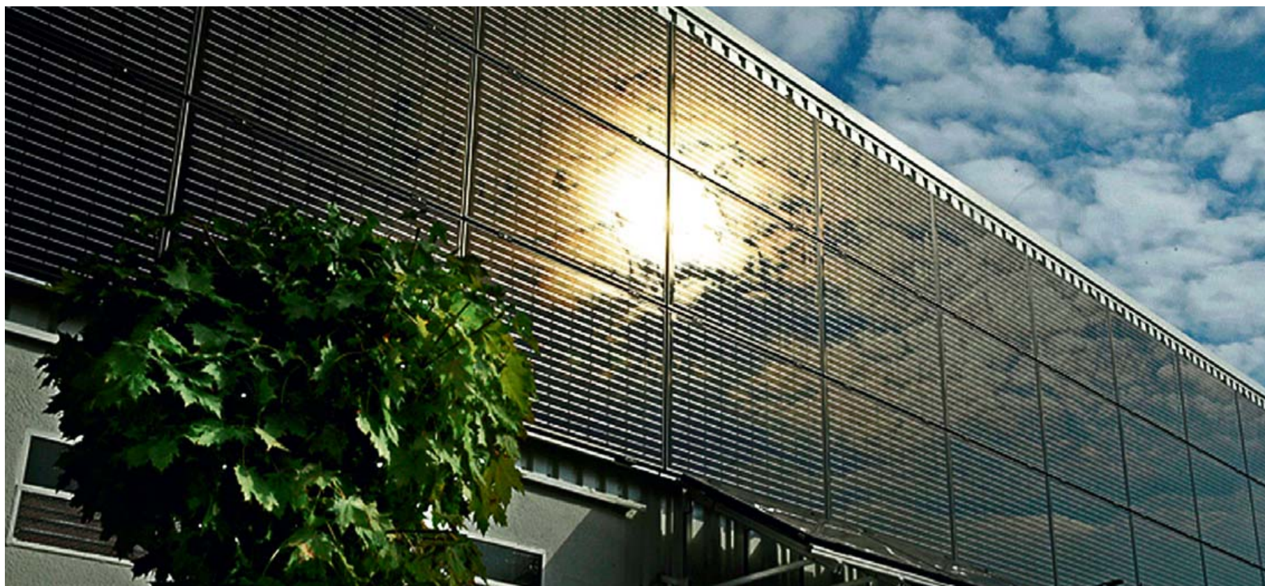
Die Anlage des Modultyps SI-Enduro M265 ging im Juli 2016 auf dem Dach und an der Fassade eines Gebäudes der Industriefirma Schahl in Winterbach in Betrieb. FOTO: WK
